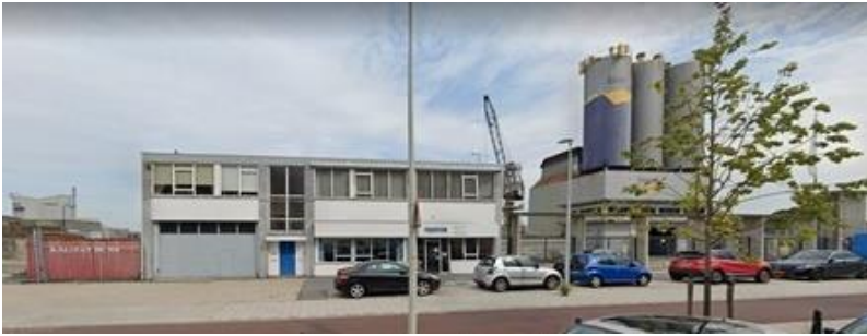
Foto B4-4 Binckhorstlaan 358-362 (bron: Google streetview)
