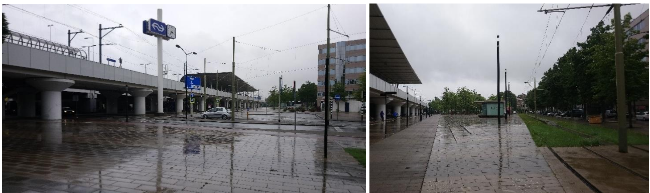
Foto 2-8 Station Voorburg (in oostelijke richting) (bron: Arcadis, 2020)
